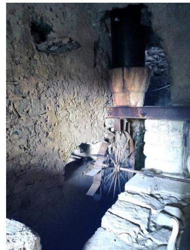
Fig. 32 – Cartiera: Ruota metallica lì dove c'era la ruota lignea del paratore (nota 7)
