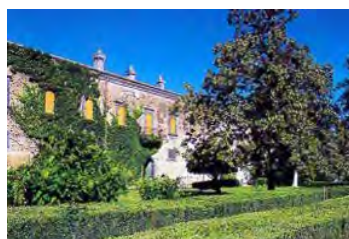
Fig. 40 – Vista della Villa con il roseto di destra, 2006 (vedi nota 9).
