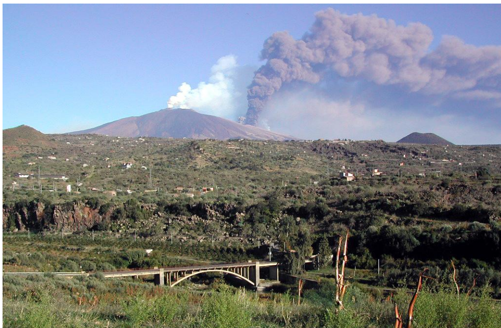
L'Etna in eruzione (2002). In primo piano il ponte Passopaglia sul percorso del Simeto
